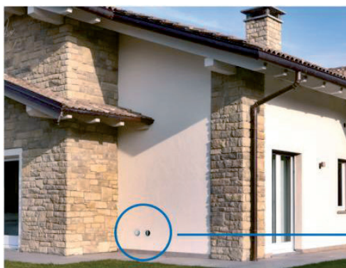
Udvendig er der ingen ude del, kun 2 diskrete spjæld.
